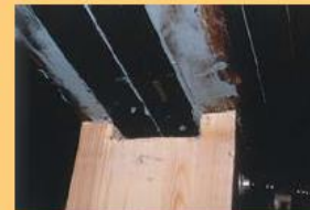
Релаксация на деформацията на дъбова греда чрез гъве по пистолет. Вкарване на ленти Sika®CarboDur® H514
